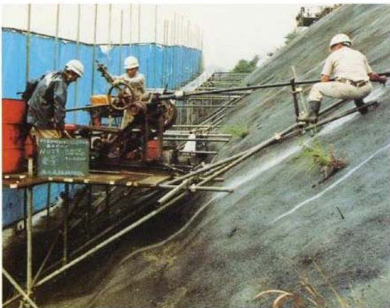
地すべり対策などの水平ボーリングも行います
