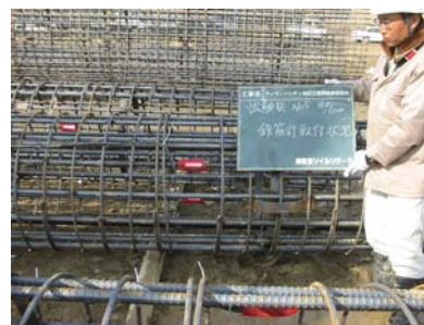
主筋への鉄筋計の取り付け状況
