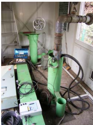
揚水状況 （揚水井 取水状況）
