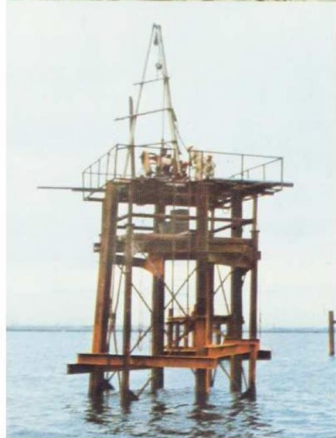
水上でも陸上と同様の地盤調査が可能です
