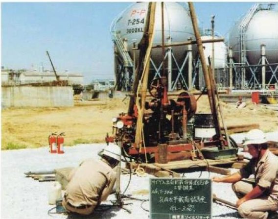
必要に応じて原位置試験を行います （孔内载荷試験実施状況）
