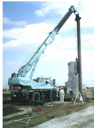
写真-1 重錘質量 20kN 程度までの 場合の載荷装置
