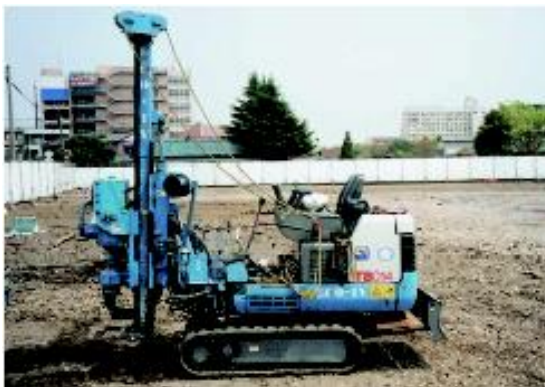
深度方向調査用ボーリングマシン
