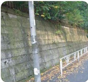
▲大谷石積み擁壁
