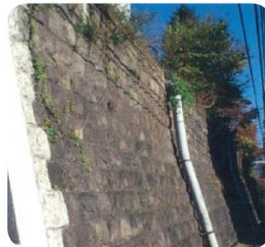
▲間知石積み擁壁
