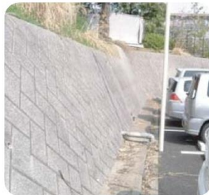
▲間知ブロック積み擁壁
