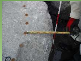
かぶり厚さ測定状況
