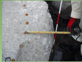
かぶり厚さ測定状況
