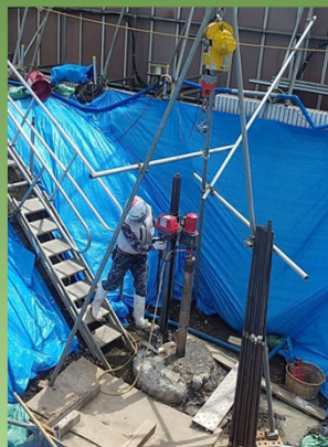
コア削孔状況
