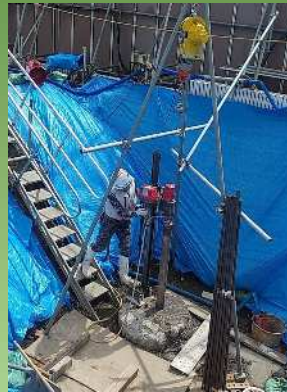
コア削孔状況
